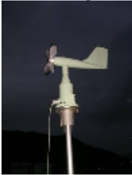
高さ20mに風向風速計を設置
